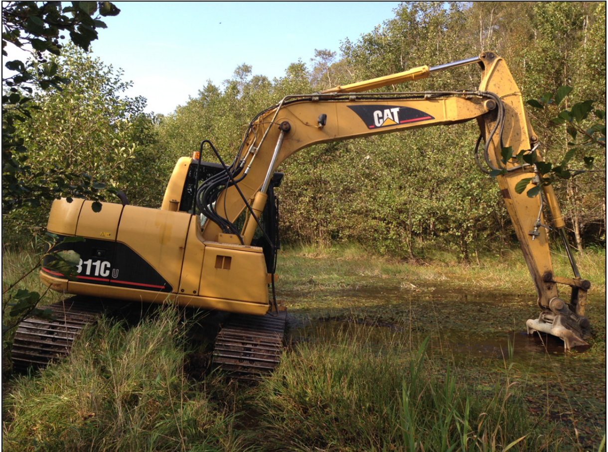
Figur 21: Fjerning av mudder og planter i nedre del av Øynåkvitlen, 18.09.2014. (Foto: Trond Erik Børresen, Lyse Produksjon).
