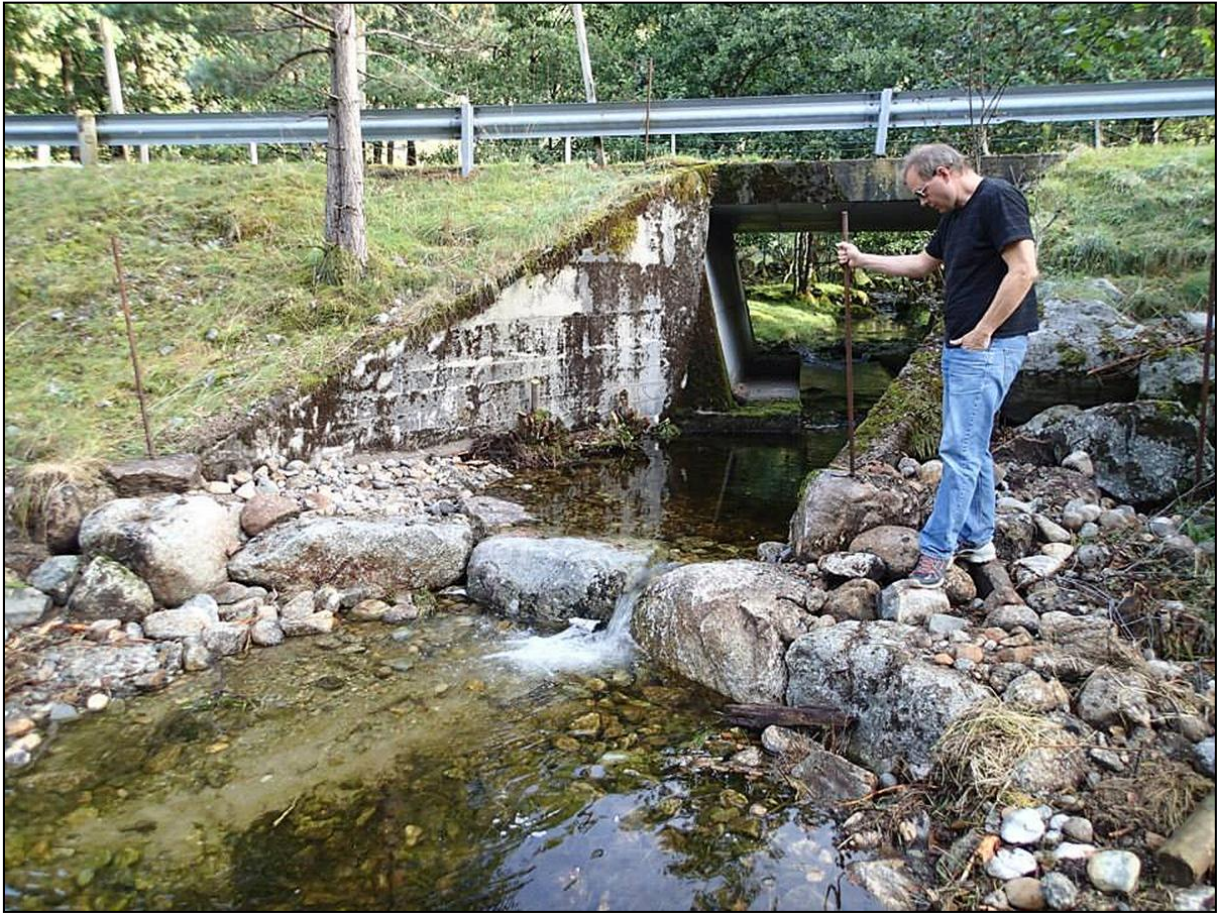
Figur 19: Kulvert i bekk ved Sagjå, etter tiltak.
