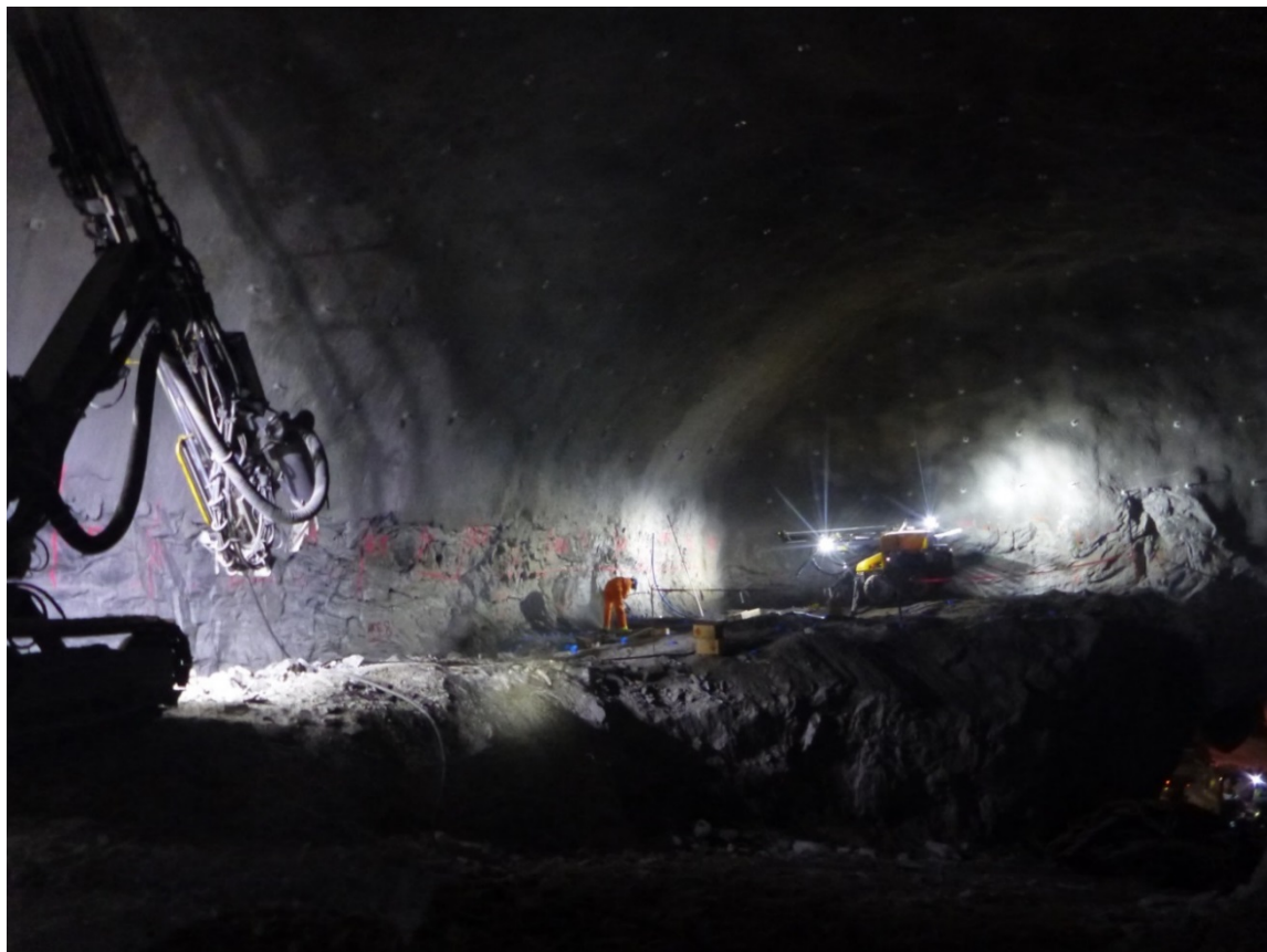
Boring for pallsprengning i kraftstasjonen.
